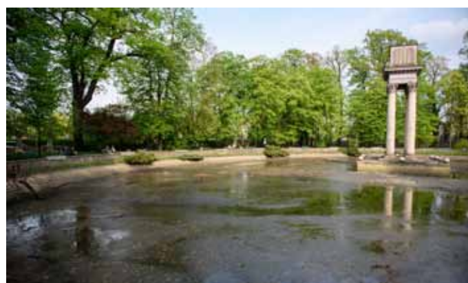
Już wkrótce rozpocznie się remont Mauzoleum gen. J. Bema.
