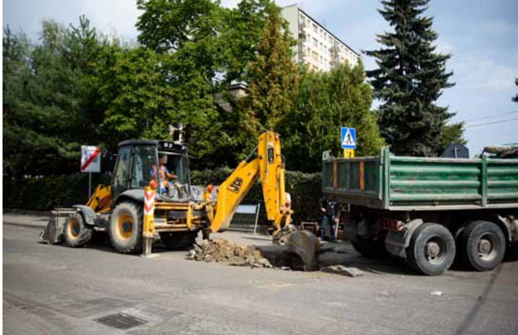
We wrześniu rozpoczął się remont ul. Pułaskiego. Finał prac zaplanowano w październiku.
