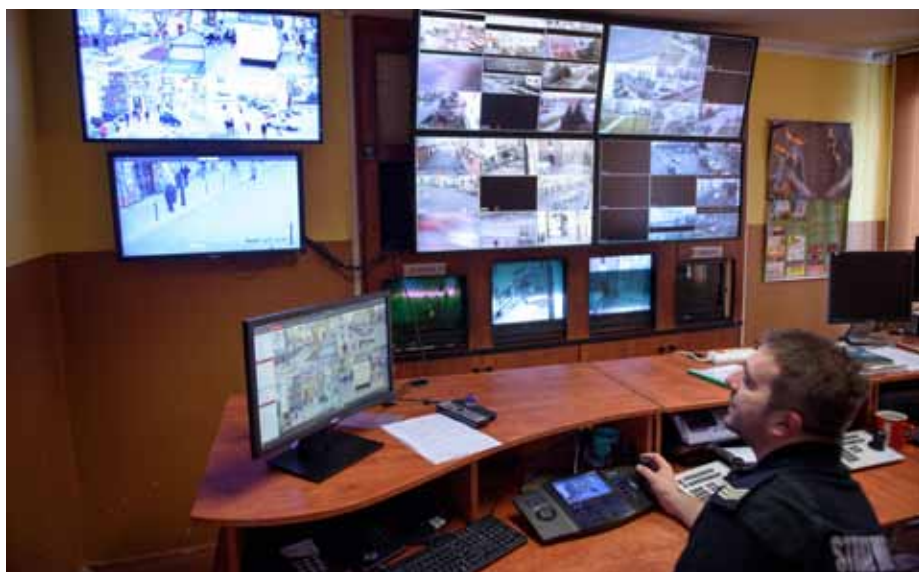
Centrum monitoringu straży miejskiej
