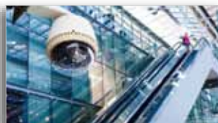
Rozbudowa systemu CCTV (35 szt), budowa systemu ANPR (127 szt)
