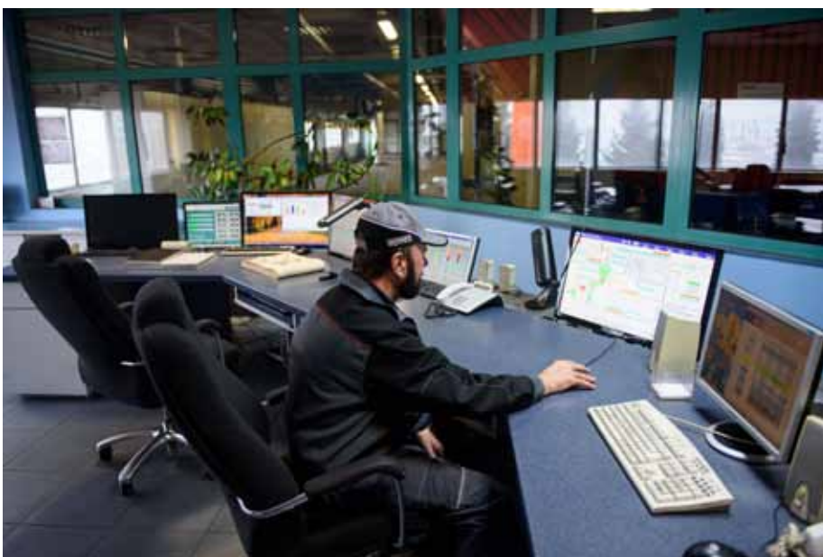
Nowoczesna sterownia ciepłowni „Piaskówka”
