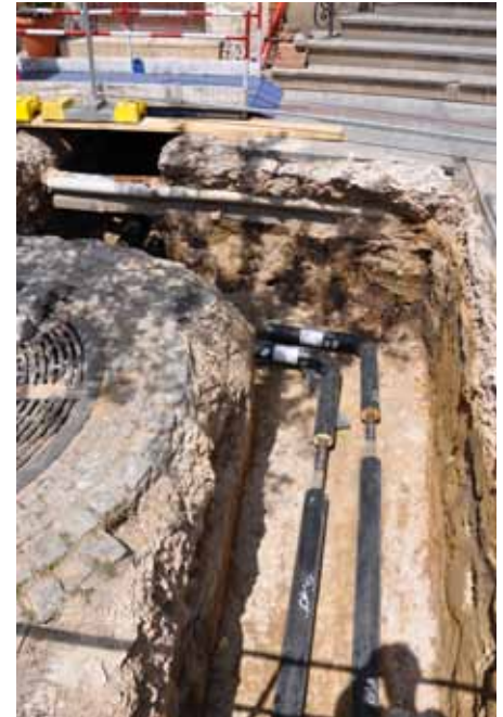
Dzięki rurom położonym pod rynkiem MPEC podłącza do miejskiej sieci budynki na starówce
