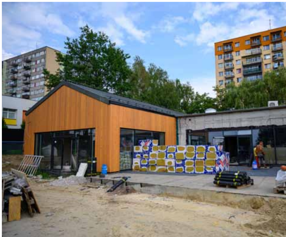
Trwają prace wykończeniowe na terenie nowego Domu Kultury na osiedlu Westerplatte, które powinny zakończyć się w trzecim kwartale
