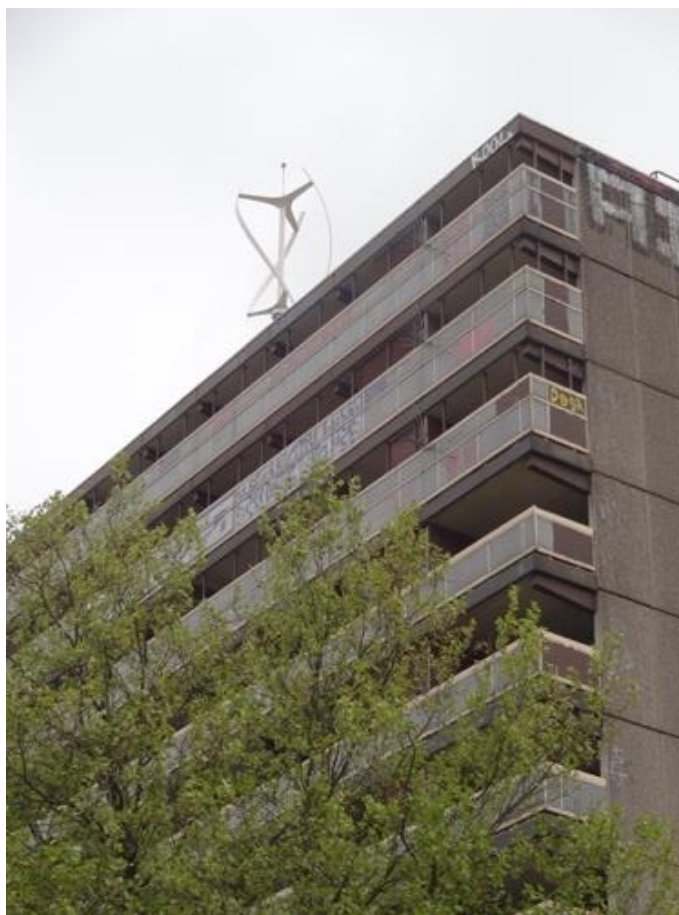
Rysunek 10. Zdjęcie mikroinstalacji wiatrowej na dachu budynku mieszkalnego 75
