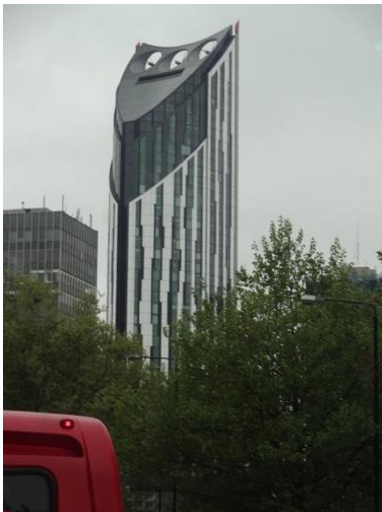
Rysunek 9. Zdjęcie małych wiatraków na dachu biurowca 72
