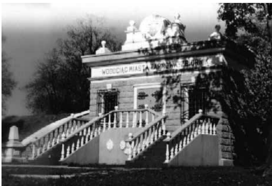
Zbiornik Tarnowskich Wodociągów
