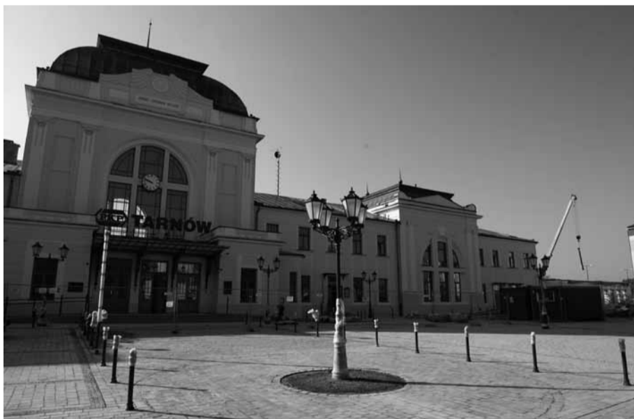
Rok 2010. Stuletni dworzec po remoncie
