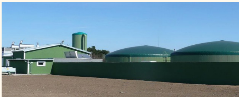
Zdjęcie 14: Biogazownia rolnicza w Koczale 37
