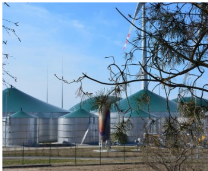
Zdjęcie 2: Elektrownia biogazowa w Darżynie (woj. pomorskie) 5
