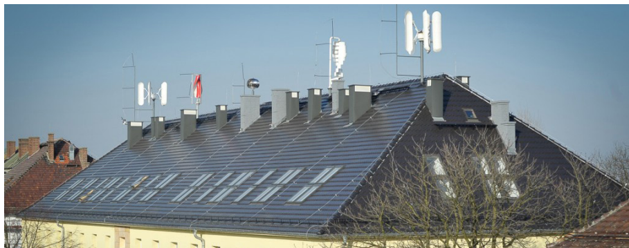
Zdjęcie 3: Turbiny pionowe na dachu budynku Instytutu Elektroenergetyki i Energii Odnawialnej – Politechnika Opolska
