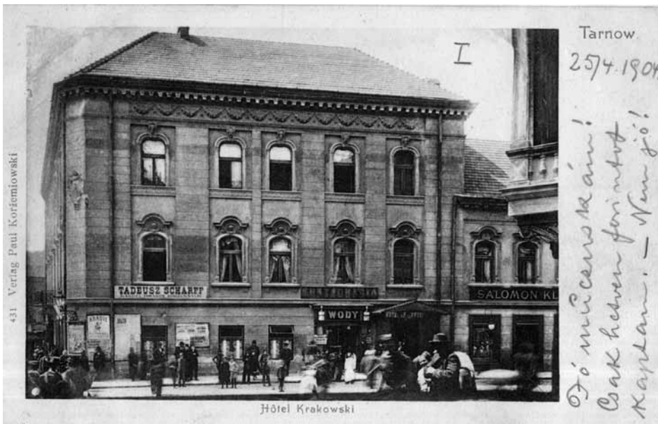
Budynek dawnego Hotelu Krakowskiego, na rogu ul. Wałowej i ul. Krakowskiej, który przebudowywał S. Zaremba
